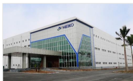
ベトナム工場外観
