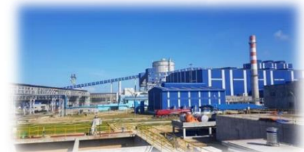
ホアファットグループの工場
